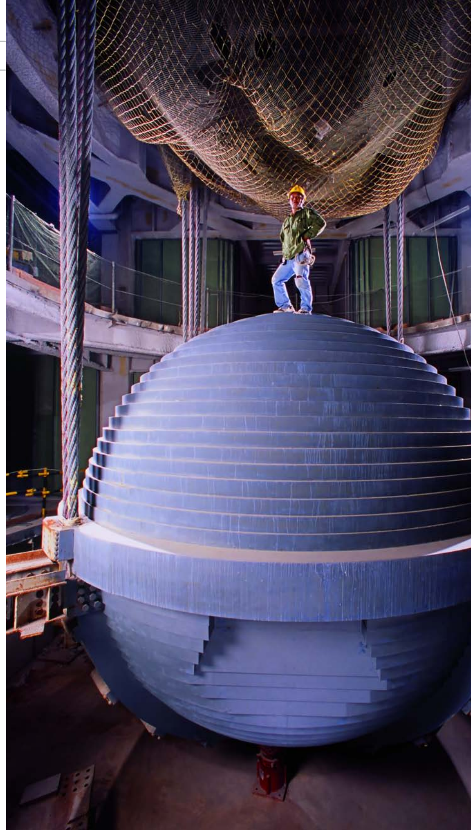
Ansicht des weltgrößten Schwingungstilgers im Rohbau von Taipei 101. Noch fehlen die Vergoldung der aus 41 Stahlscheiben im Gebäude montierten Kugel sowie ihre Stoßdämpfer
